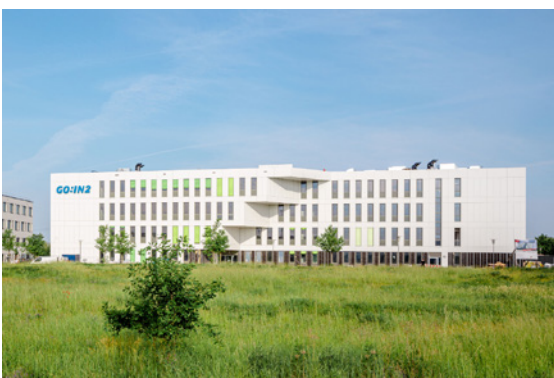
Solaranlage auf Haus 19 in Golm © Universität Potsdam / Daniel Birr
