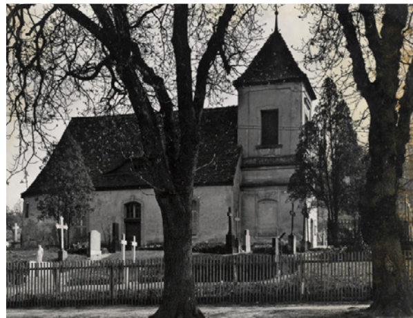
▲ oben: Alte Dorfkirche Golm von Süden 1942 darunter: Alte Dorfkirche Golm von Norden 1942
